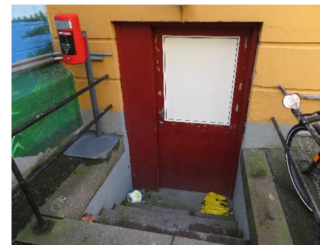
Dør til gennemgang mod gade
