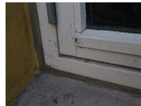
Fuger på vindue mod gård
