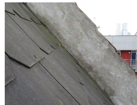
Brandkam uden skader
