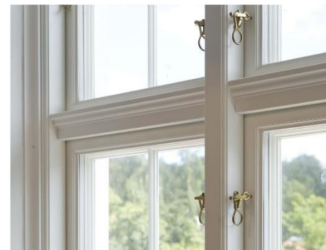
Koblet vindue set indefra
