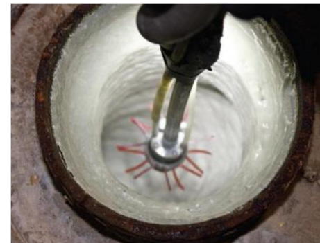
Eksempel på foring af faldstamme med "relining"
