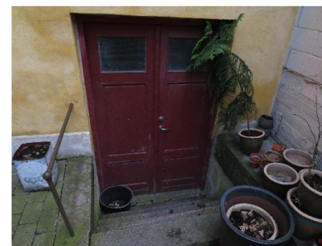
Dør til gennemgang mod gård
