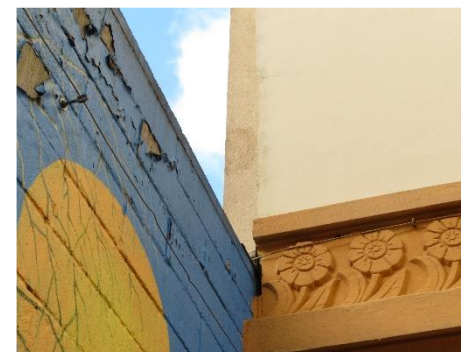
Efterisolering på gavl
