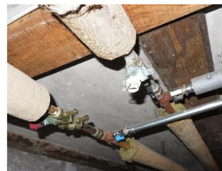
Defekt strengreguleringsventil
